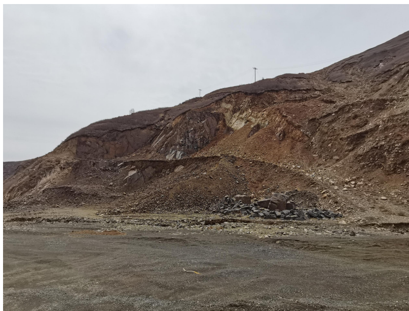
图 8-2-1 CK1 试采场边坡现状
